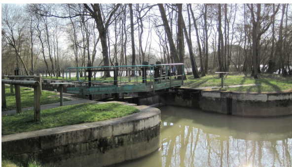
Ecluse sur la Seille canalisée © V. Serna/MIGPC 2014
