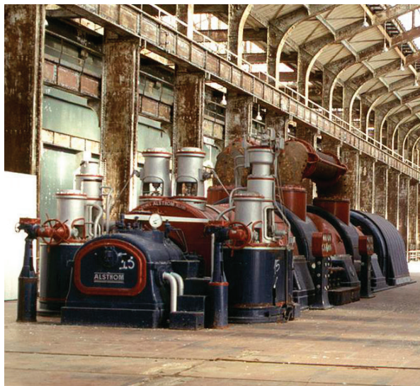
Turbo-alternateur de l'ancienne centrale EDF de Saint-Denis Photo Jean-Bernard Vialles
