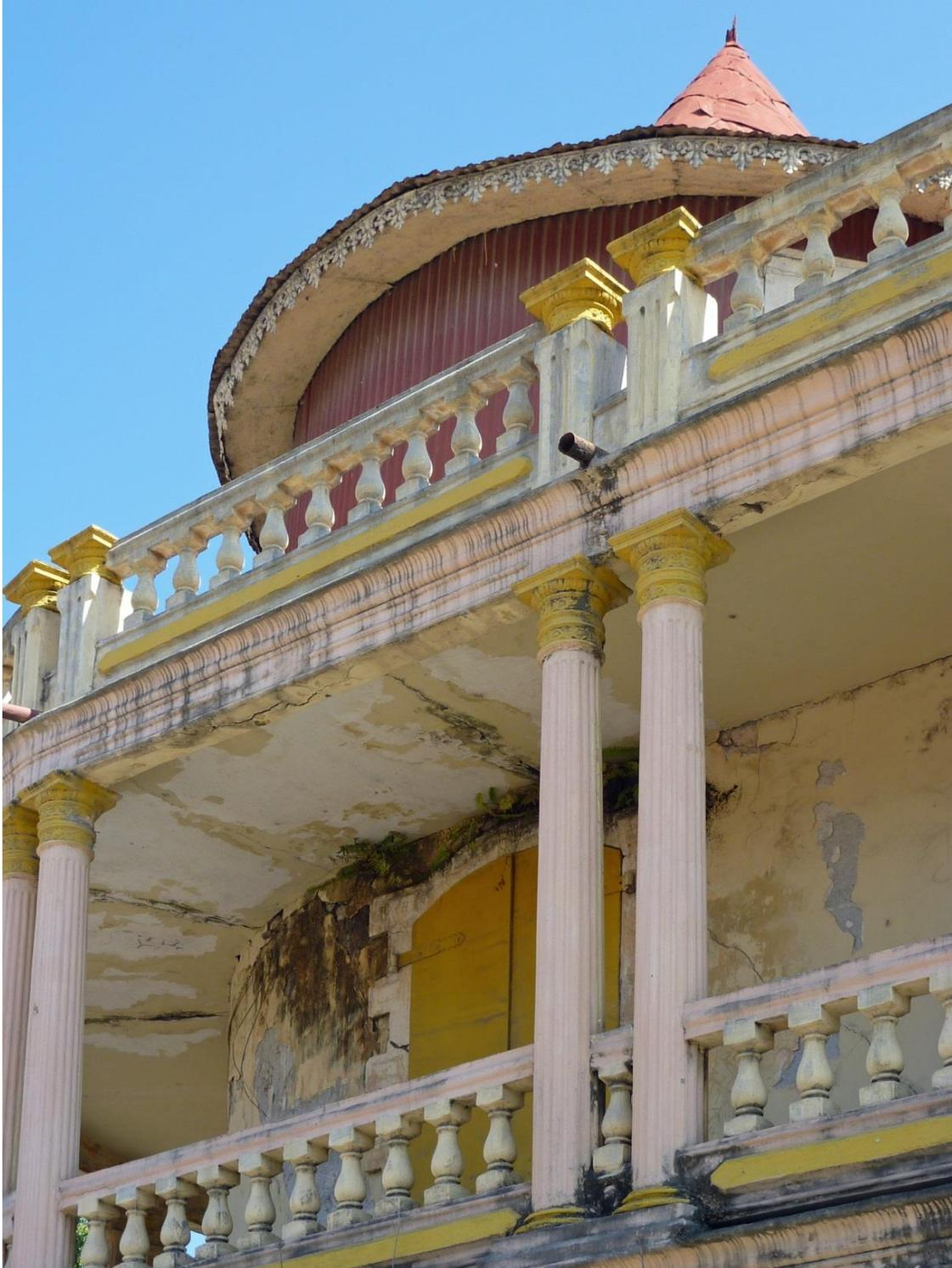
Sans doute le plus bel exemple de doubles colonnes à chapiteaux et de garde-corps à balustre en béton moulé HAJAC0685.
