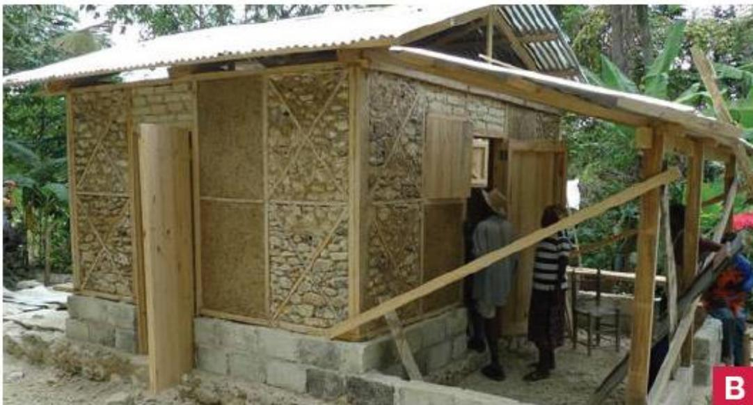
Chantiers du programme de reconstruction soutenu par Misereor (ONG allemande) : (a) ossature bois avec remplissage en clissage et briques en terre crue ; (b) ossature bois avec remplissage en maçonnerie de pierres avec mortier terre. (c) CAIMI Annalisa... *Op. cit.*
