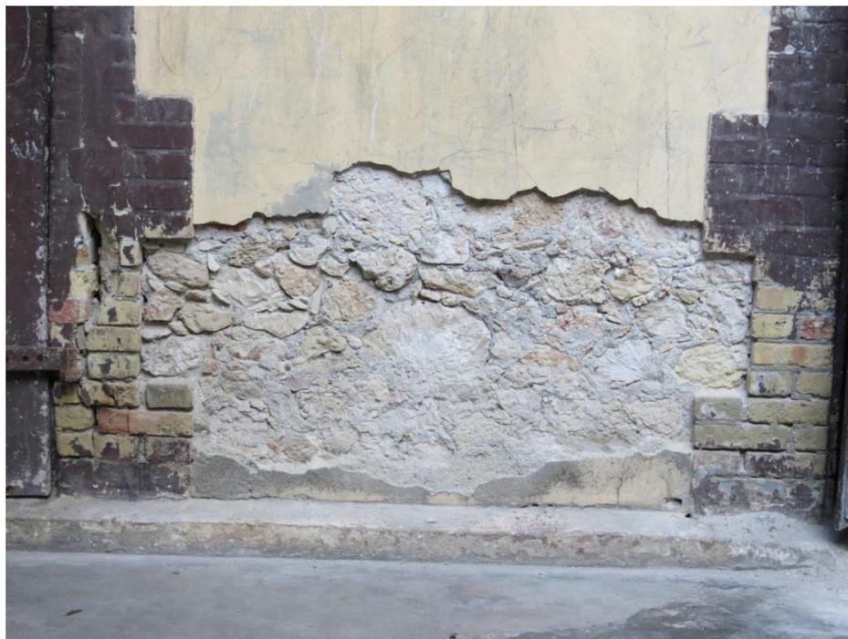
HAJAC0160. Détail de mise en œuvre de chainages en briques et d'une maçonnerie en moellons de corail recouverts d'enduit.
