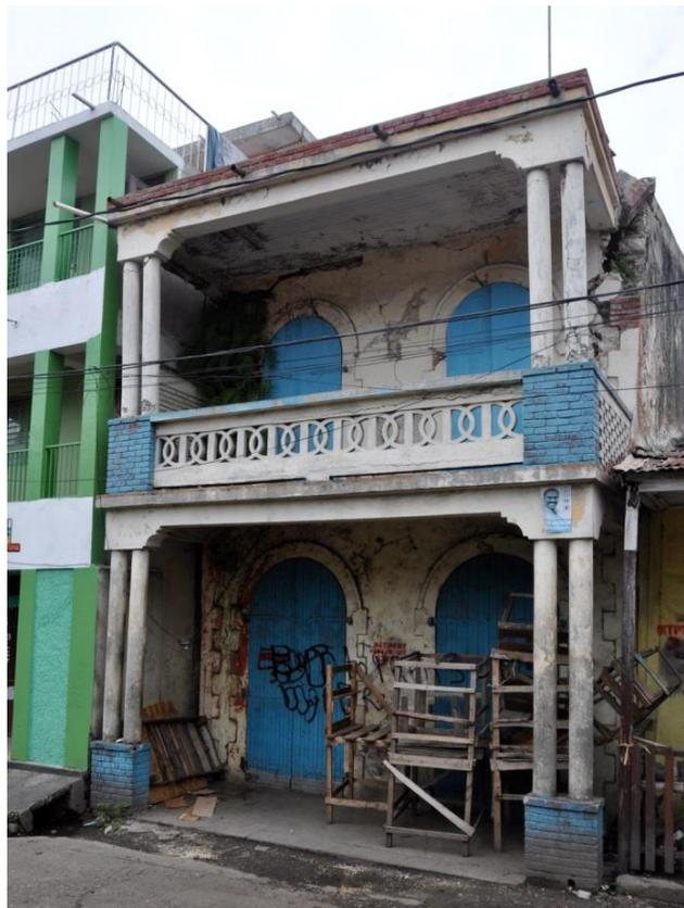
HAJAC0590. Autre exemple où les galeries d'origine ont été remplacées par un dispositif en béton.
