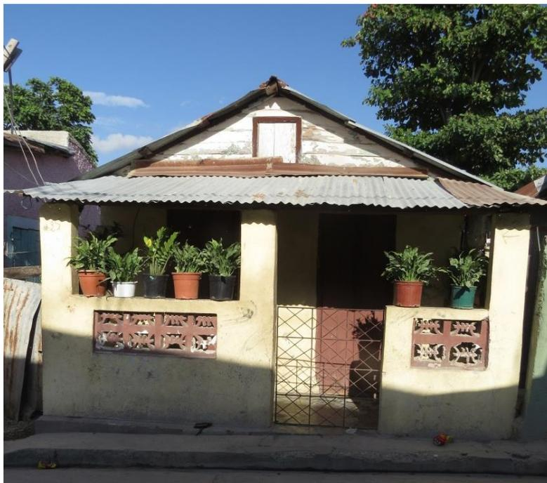
Exemple de galerie sous appentis pour une maison en rez-de-chaussée à mur pignon sur rue dont la structure porteuse a été remplacée par d'imposants poteaux béton et un épais garde-corps maçonné
