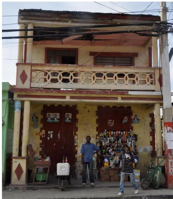
Deux exemples de mise en œuvre de doubles poteaux en béton HAJAC0125 et HAJAC0082
