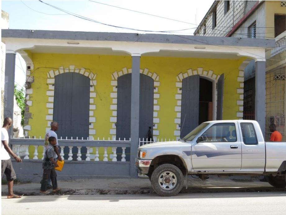
Exemple de maison en rez-de-chaussée construite en maçonnerie traditionnelle et dont la toiture a été refaite (HAJAC0083), des poteaux en béton supporte le toit.
