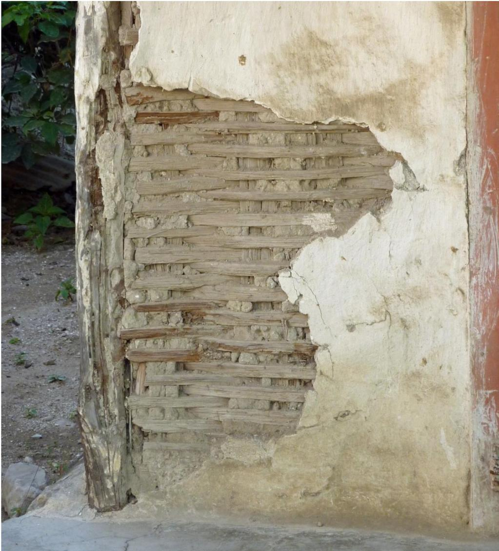
Exemple de mise en œuvre de clissage sous enduit, hors du périmètre de l'étude d'Inventaire général. © ISPAN, 2013.
