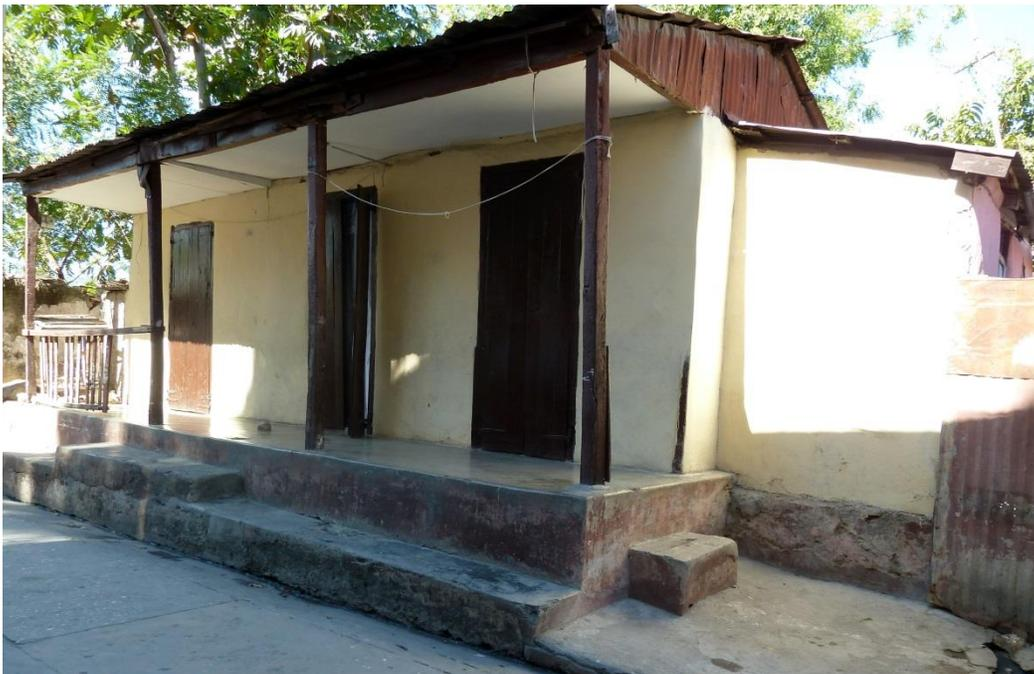
Exemple de maison en rez-de-chaussée en maçonnerie traditionnelle avec mur gouttereau sur rue avec galerie sous avant-toit HAJAC0246
