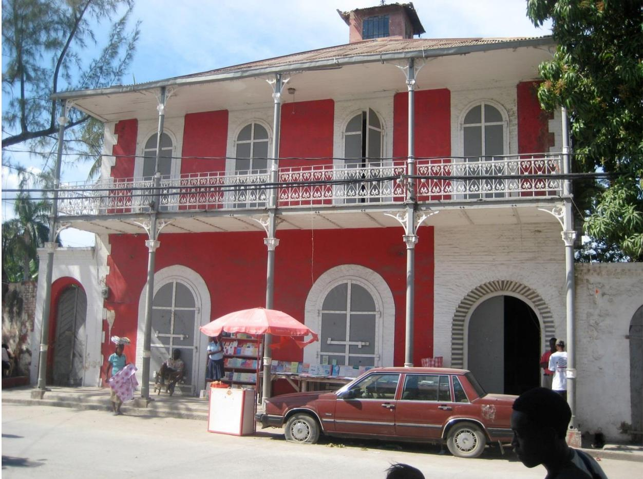
Exemple de maison à éléments importés avec galerie sous avant-toit HAJAC0009, avec, couvrant la galerie, au dernier étage, une fermeture d'avant-toit lambrissée.
