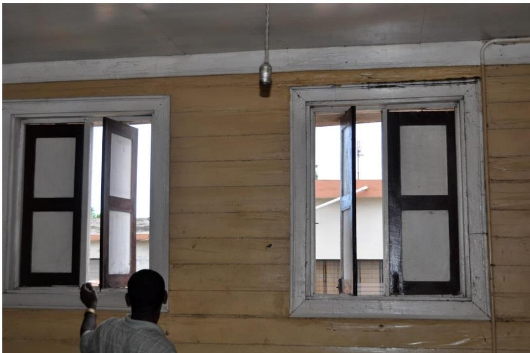
Système de volet pivotant sur leur axe permettant de moduler leur ouverture pour faciliter la circulation de l'air et la protection du soleil. HAJAC0523
