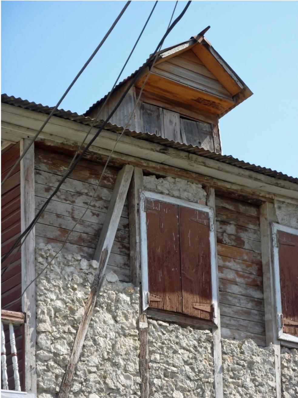
Détail d'une structure bois avec remplissage de moellon. HAJAC0141
