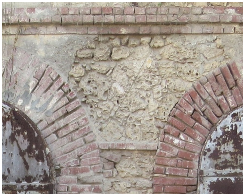
Utilisation du corail en moellon, détail (HAJAC0030).
