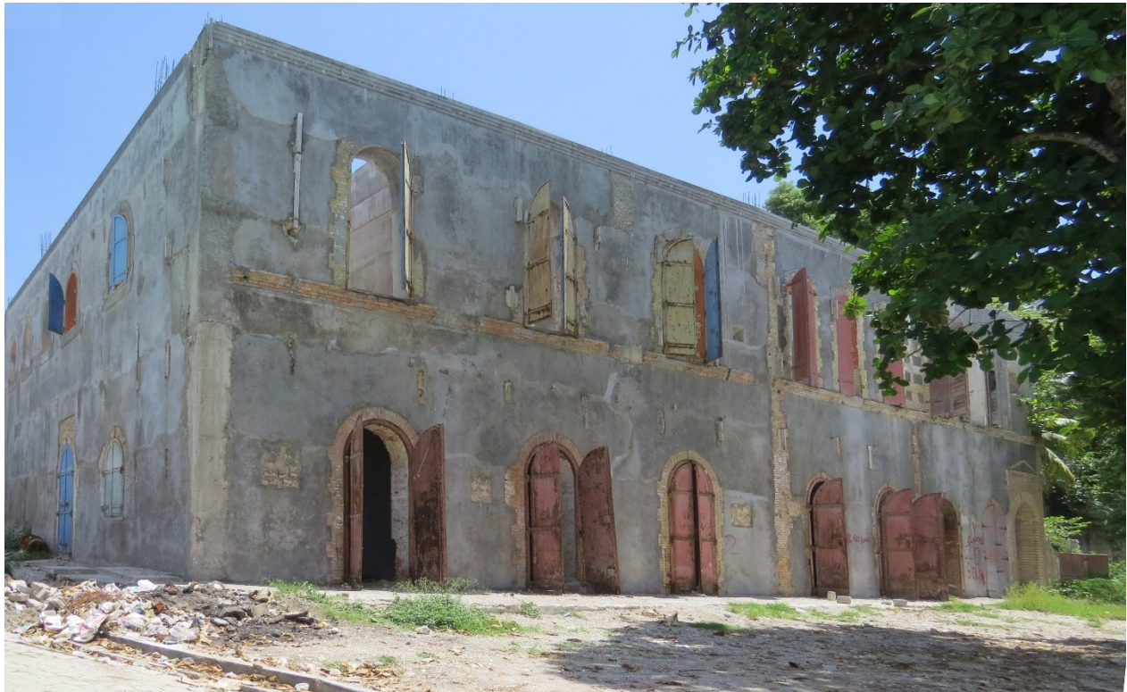
L'entrepôt-usine Madsen (HAJAC0654) face à la douane et au wharf du port.
