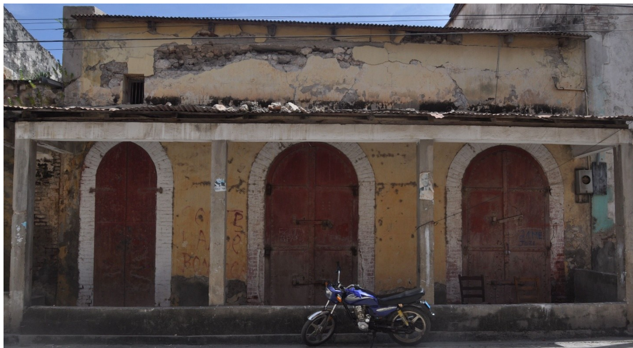
Entrepôt Boucard (HAJAC0027) avec sa galerie sous appentis en charpente béton.
