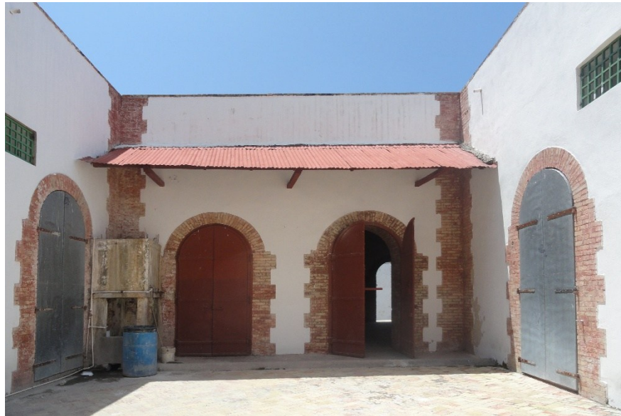
Auvent sur l'élévation d'un mur de la cour intérieure de l'entrepôt Vital HAJAC0280
