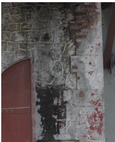
Chaînage d'angle en brique enduite avec faux-appareil de pierre de taille (HAJAC0022).
