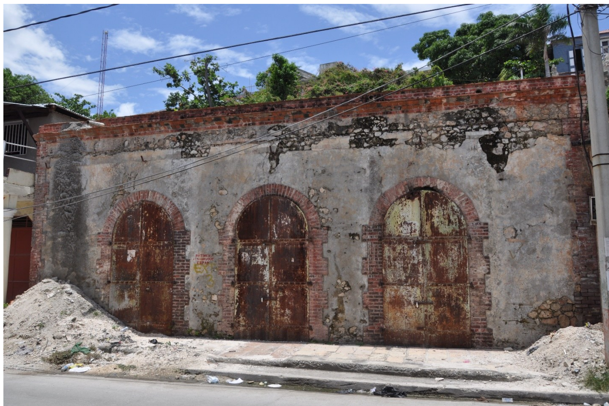
Entrepôt en moellon avec encadrements de baies, chaînages d'angle et corniche en brique apparente (HAJAC0039).
