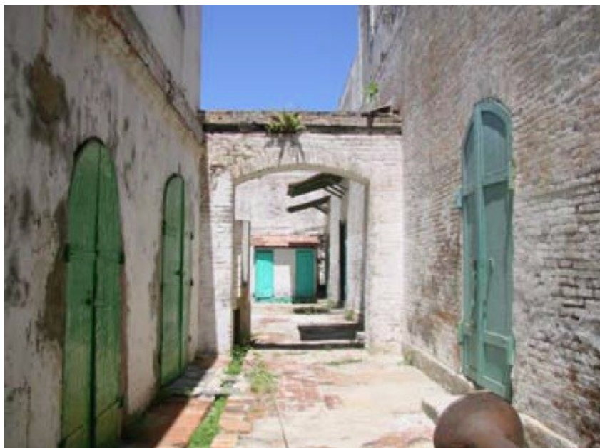
Entrepôt Vital (HAJAC0029). Circulation entre les différents entrepôts, en cœur d'îlot. © Cécilia Corragio 2007.
