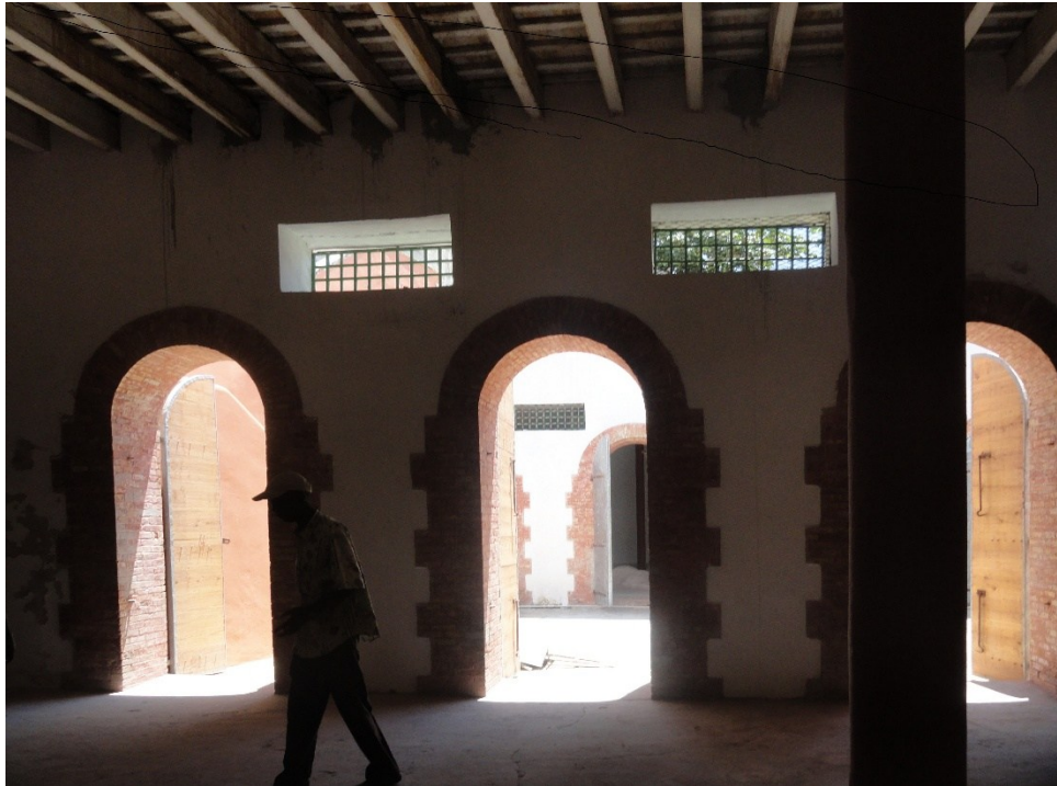
Intérieur de l'entrepôt Vital (HAJAC0280) en 2012 après restauration. On distingue la cour intérieur et le second bâtiment. Les portes qui ouvrent vers la cour sont identiques à celles de l'élévation sur rue.
