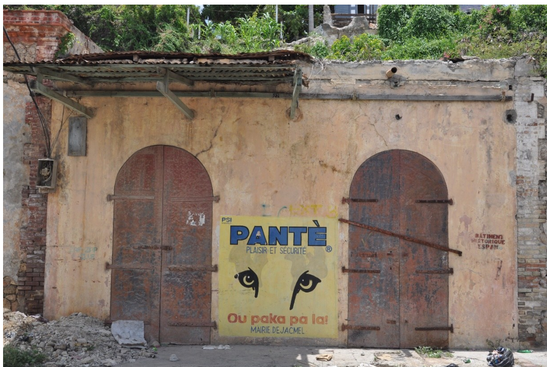
Entrepôt Boucard (HAJAC0044) avec les vestiges de son auvent en appentis.
