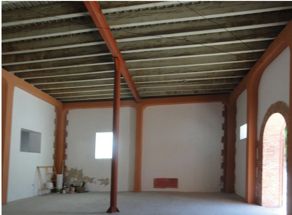
Intérieur de l'entrepôt Vital (HAJAC0280) avec poteau et poutre métalliques.
