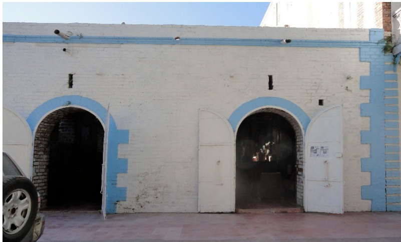
Entrepôt à gargouilles saillantes pour l'évacuation des eaux pluviales et deux jours en archères surmontant les portes (HAJAC0040).
