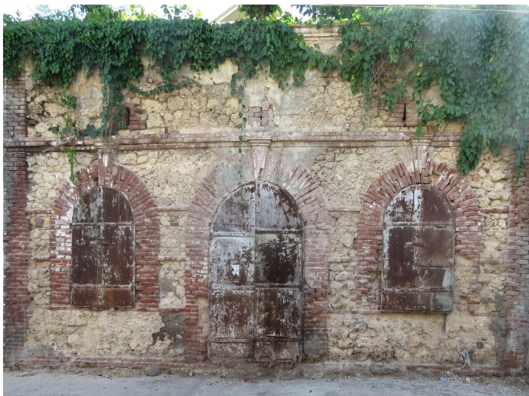
Elévation de l'entrepôt (HAJAC0030) munie de chantepleures. L'importante saillie de la corniche située en dessous joue le rôle de larmier.
