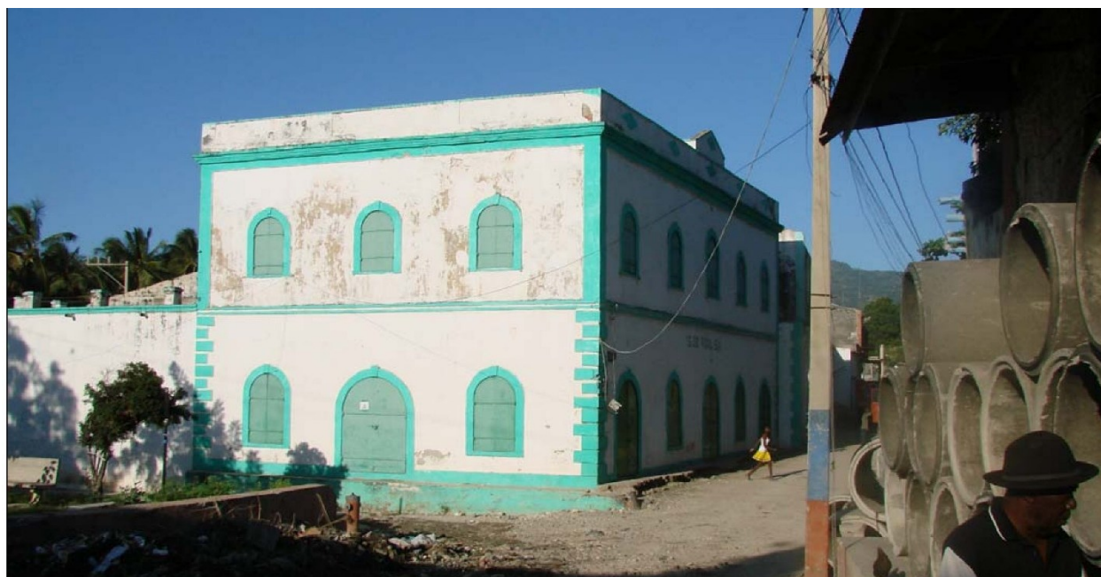
Entrepôt Vital (HAJAC0029). Le bâtiment principal à l'angle de la place de la Douane et de la rue du Commerce. © Cécilia Corragio 2007.
